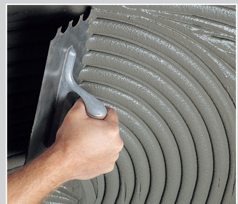
Нанесение клея LITOFLOOR K66 зубчатым шпателем (размер зубцов 15 мм)
