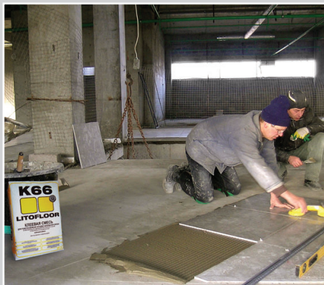
Укладка керамогранита (60x60 см) на клей LITOFLOOR K66 в торговом центре
